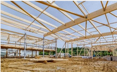
Square Collégien - 77 et ses charpentes bois
